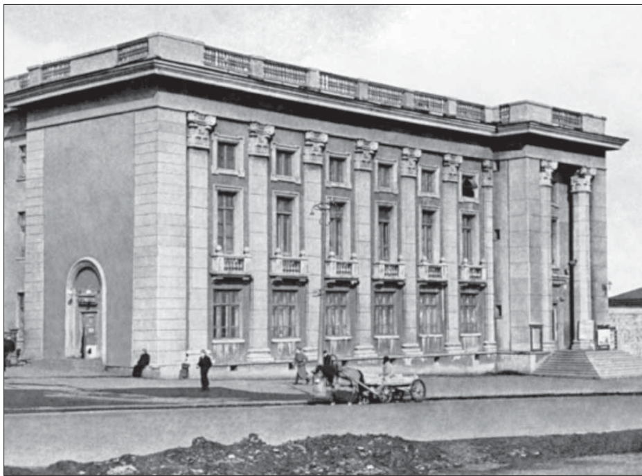
Дом инженерно-технических работ – ДИТР – торжественно открылся 31 декабря 1942 года
