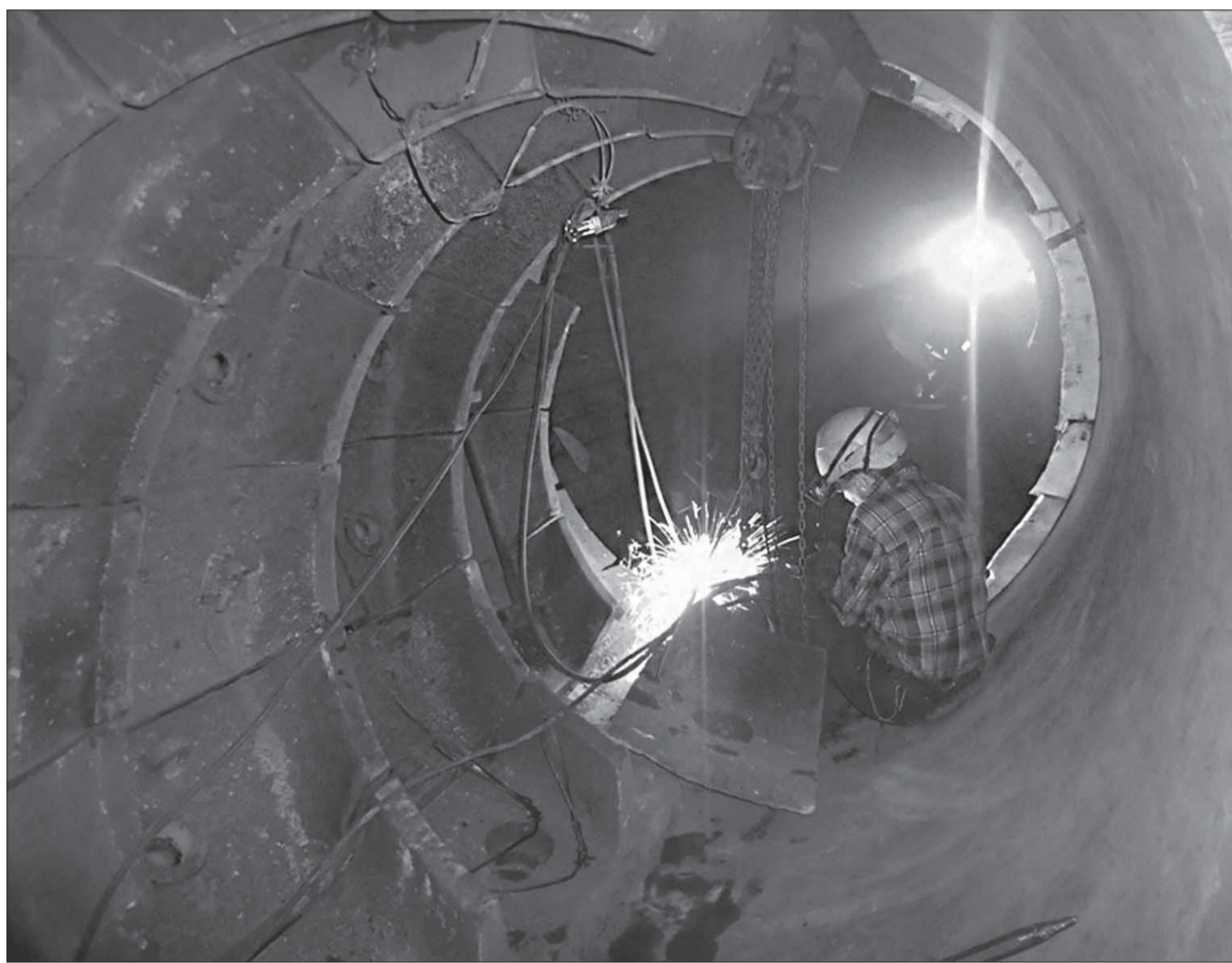
Ремонт мельницы провели быстро и качественно
