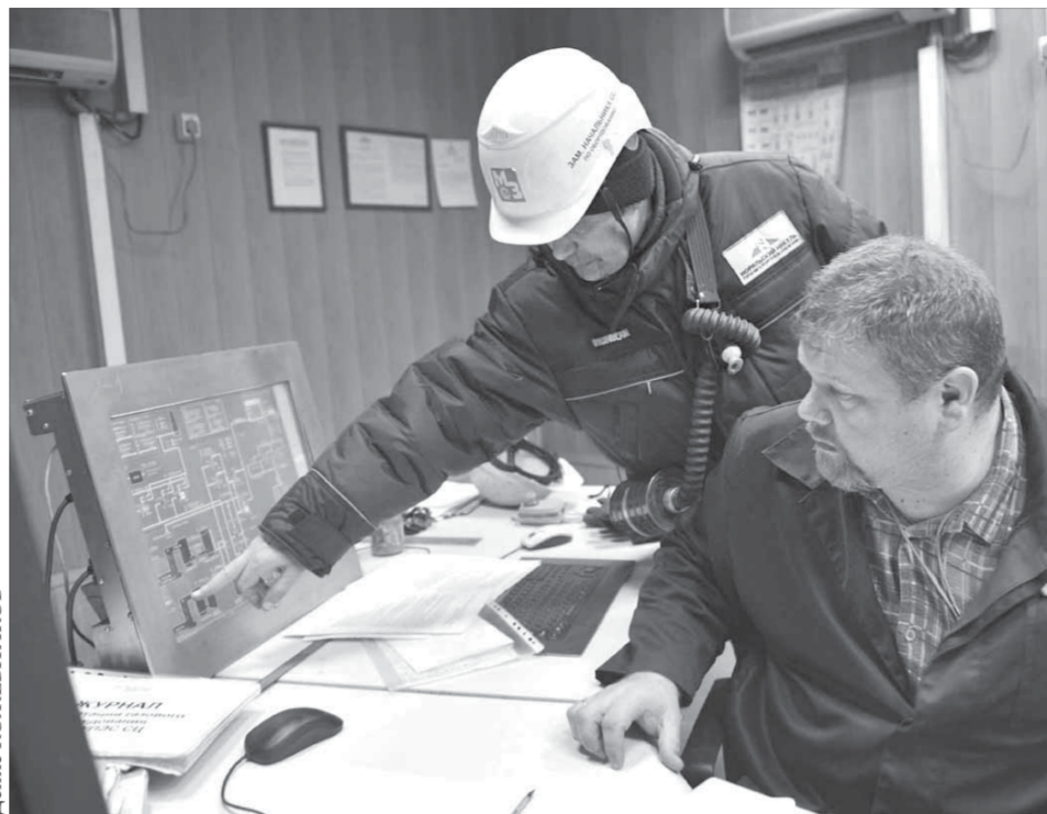
Управлять процессом будут из операторной
