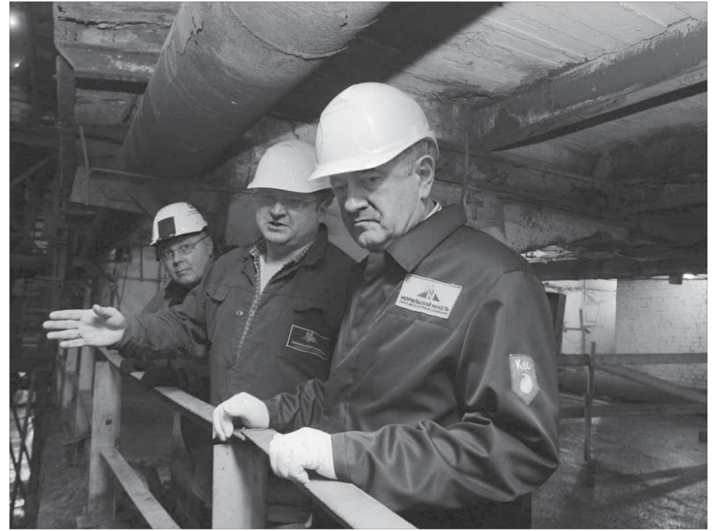
Александр Рюмин оценил процесс реконструкции
