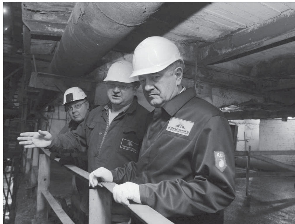
Александр Рюмин оценил процесс реконструкции
