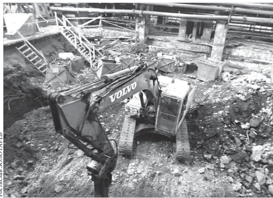
В главном корпусе фабрики ведутся основные строительные работы
