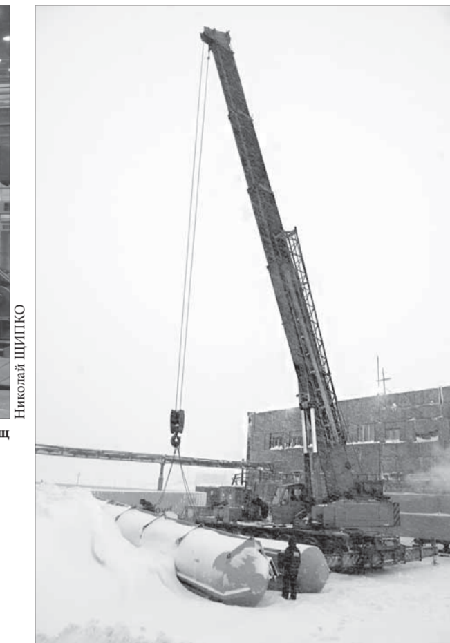
Не каждый кран поднимет 40 тонн
