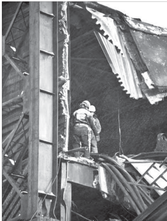
Строители начали разбирать разрушенные конструкции
