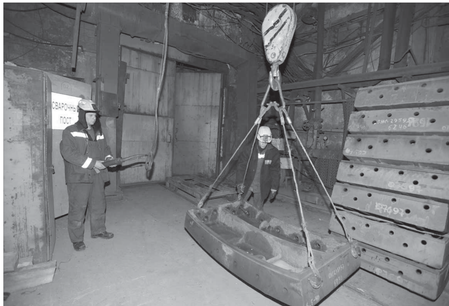
Ремонтные работы у грузовой клетки ствола
