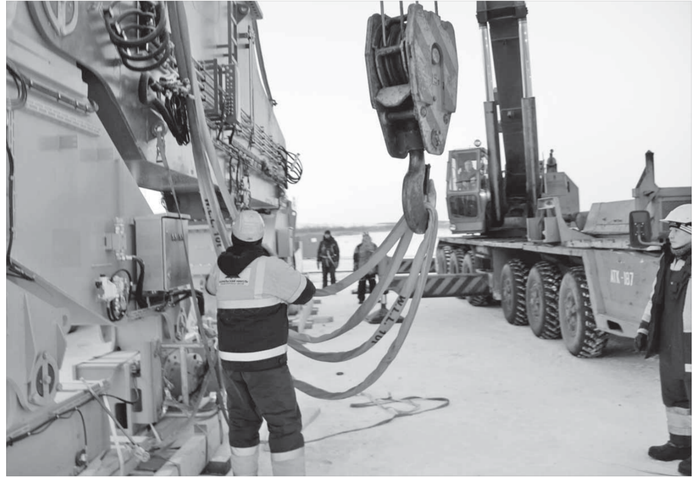
Монтаж под открытым небом
