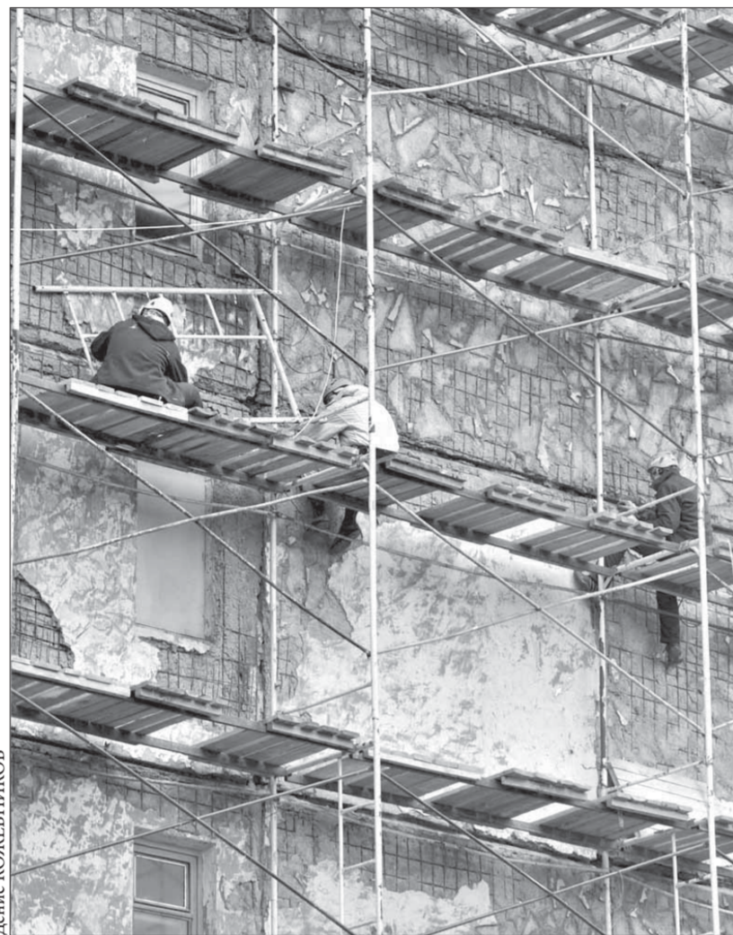
Ветровые нагрузки, дождь и морозы разрушили панели
