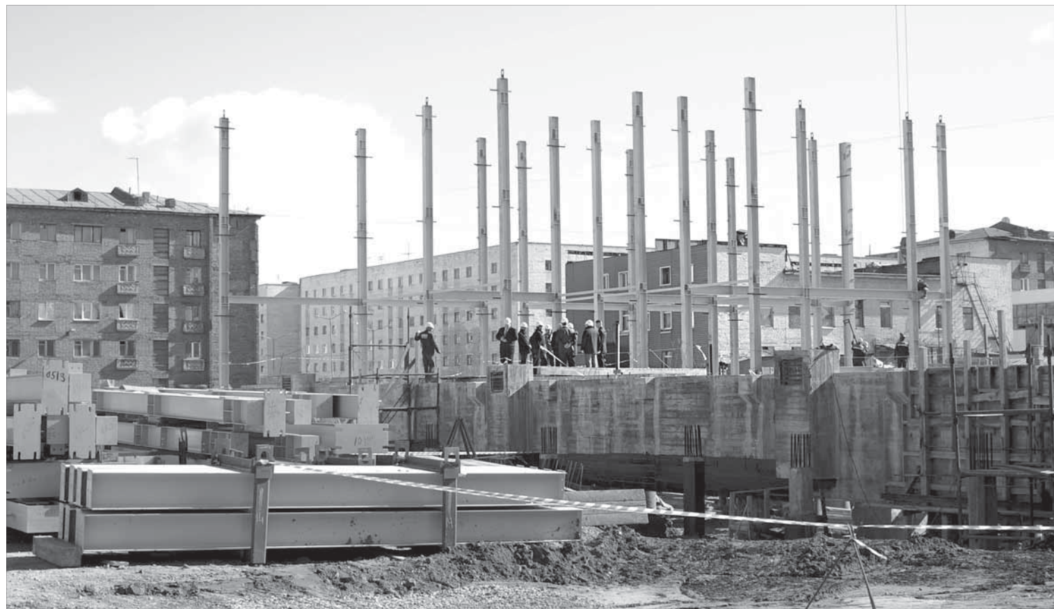
Напряженный график требует от строителей работать в три смены
