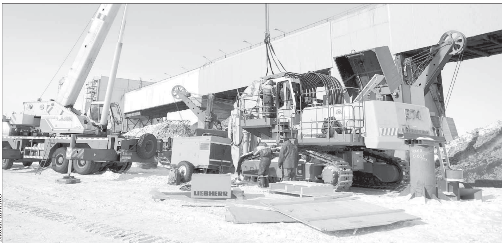
На днях экскаватор начнет полноценную работу на промплощадке
