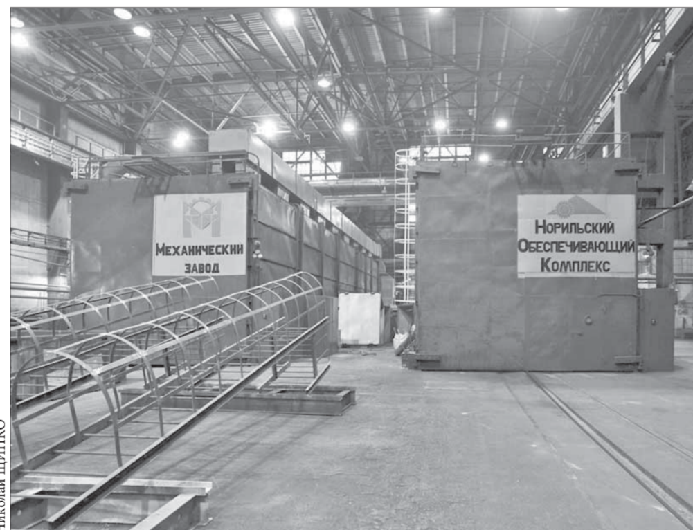
Новое оборудование позволит и красить качественнее, и экологию в цехе улучшить
