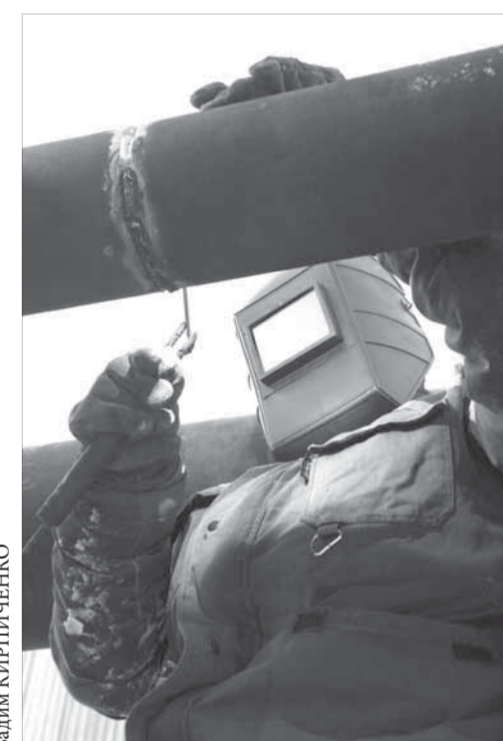
Ремонтные работы длились все лето
