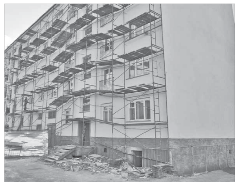
15 сентября дворовый фасад на Нансена, 60, еще в лесах
