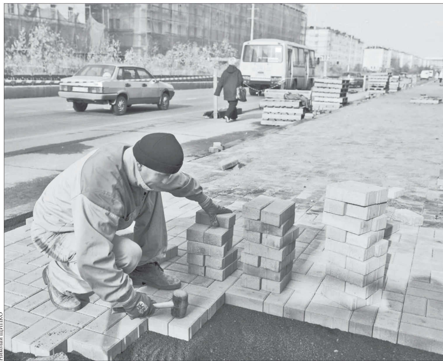
Подрядчики ремонтируют отдельные участки тротуара
