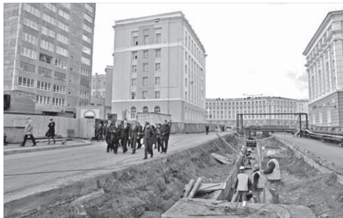
На улице Пушкина проинспектировали ремонт коллектора
