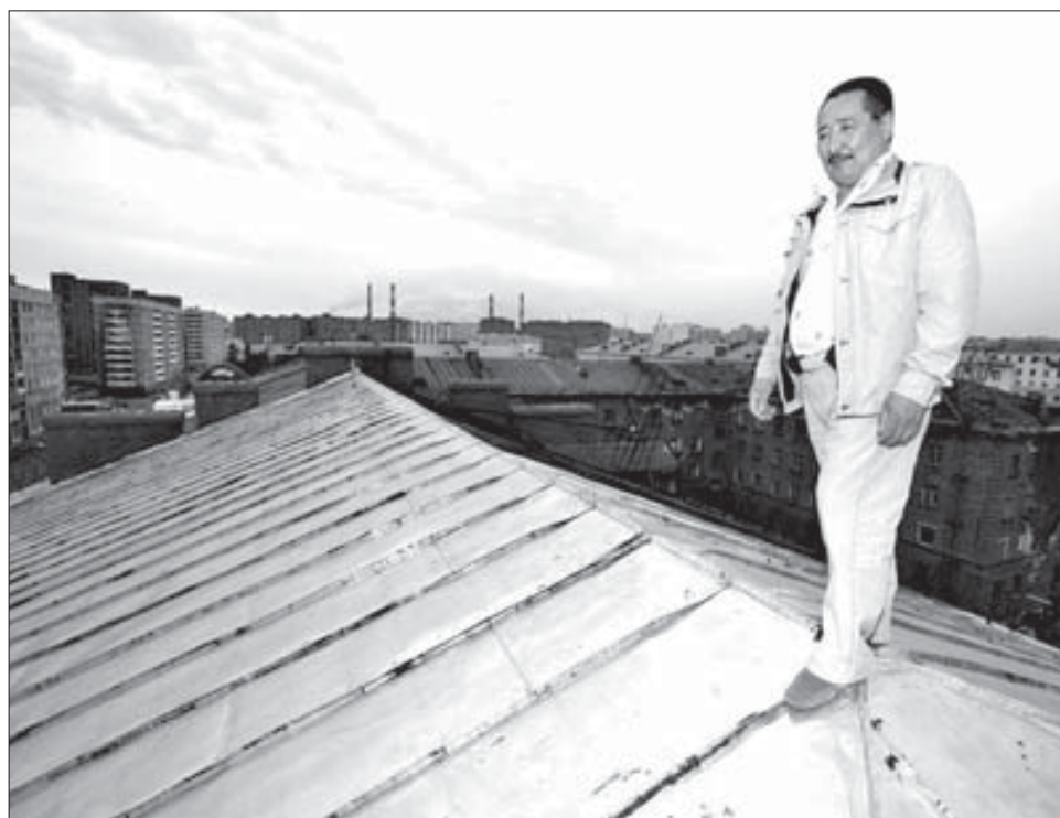
Замену кровли на Кирова, 13, подрядчики выполнили раньше срока
