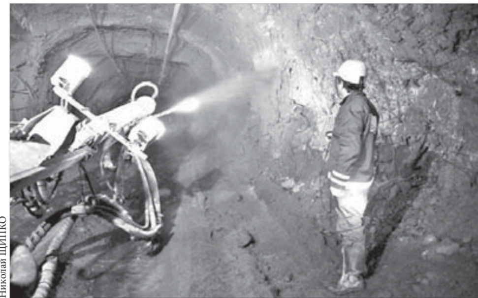
“Спраймек” покроем борта и кровлю слоем бетона
