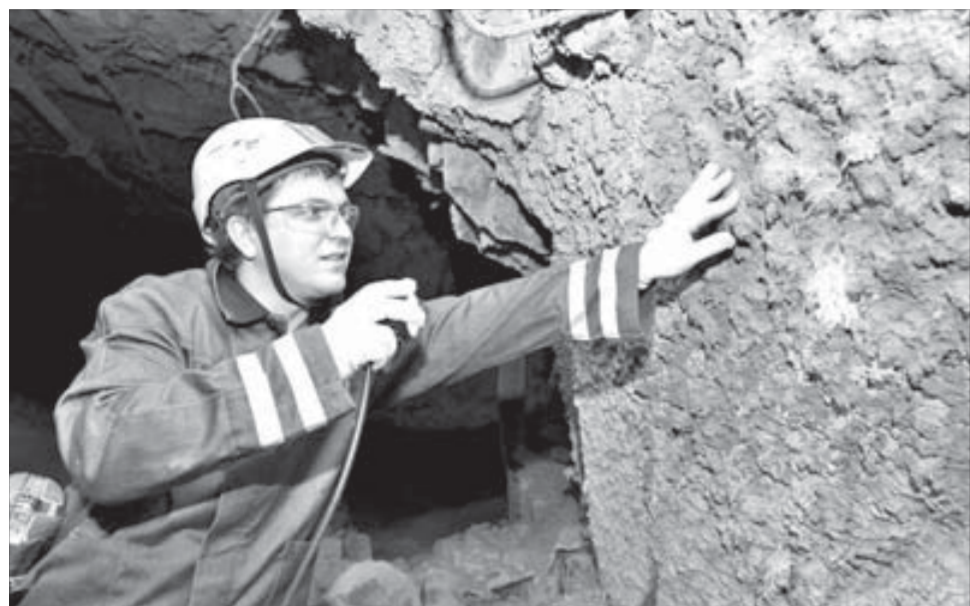
Сергей Березин объясняет, чем набрызг-бетон отличается от фибробетона
