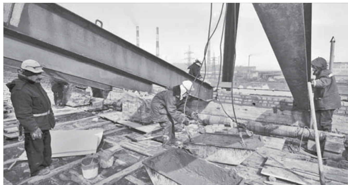
Работы с новыми элементами крыши
