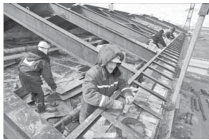
Замена кирпичной кладки
