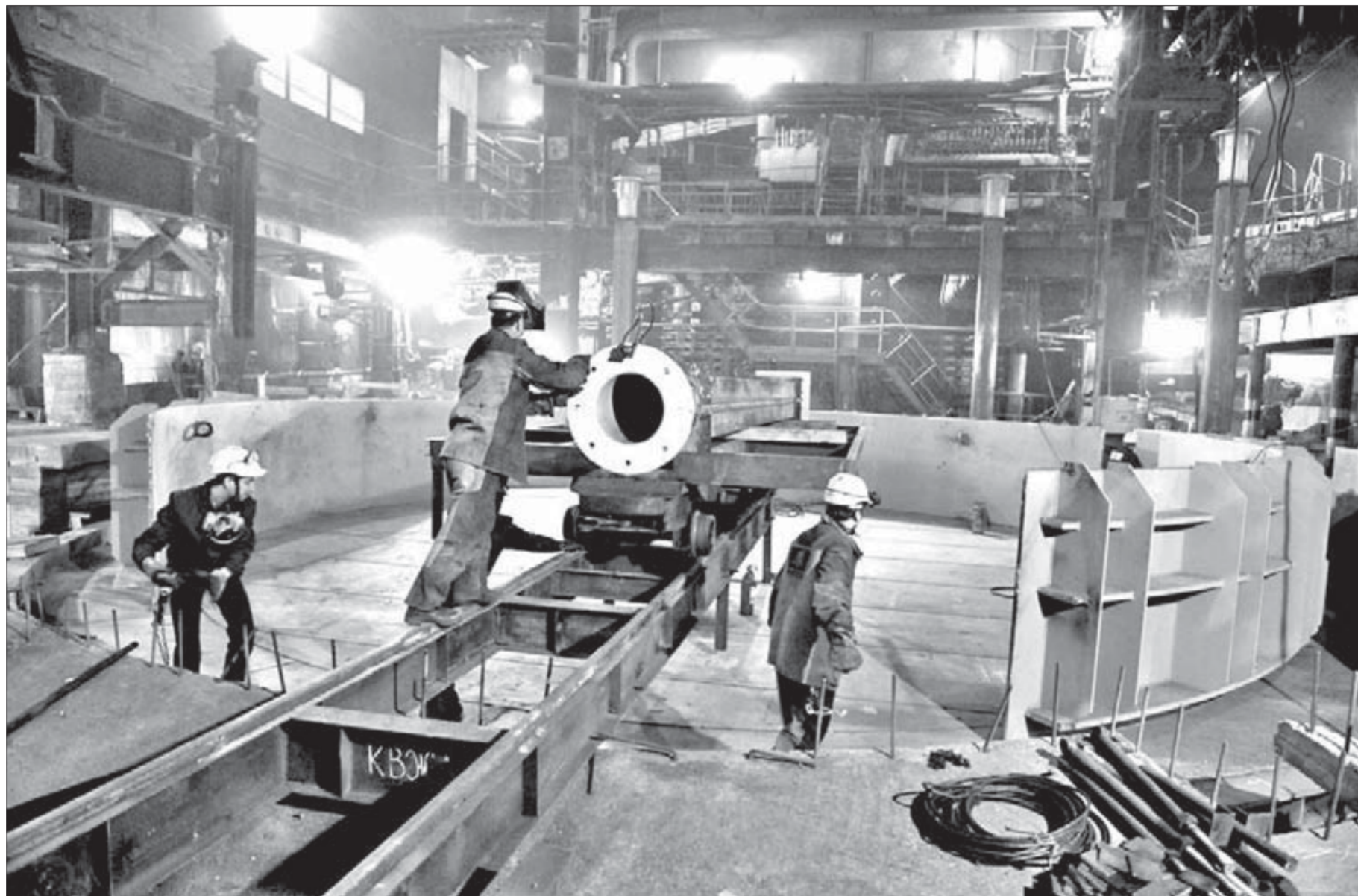
Рабочие "Норильскремонта" заняты установкой опорной колонны
