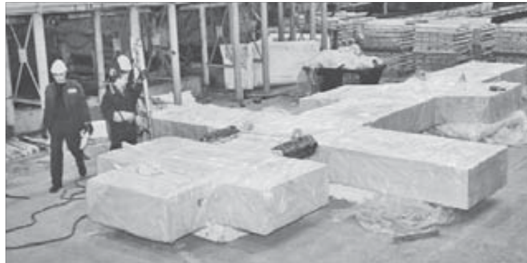
6 апреля. Завод строительных материалов и конструкций. Крест готовится к транспортировке
