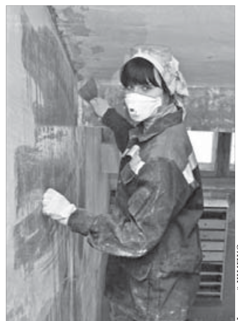
Ремонты в подъездах НЖЭК ведут полным ходом
