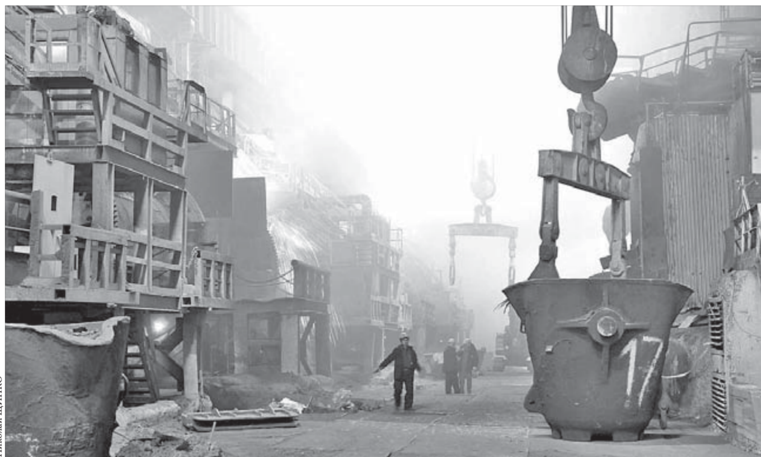
Когда одна из основных печей на ремонте, плавильный цех продолжает работать
