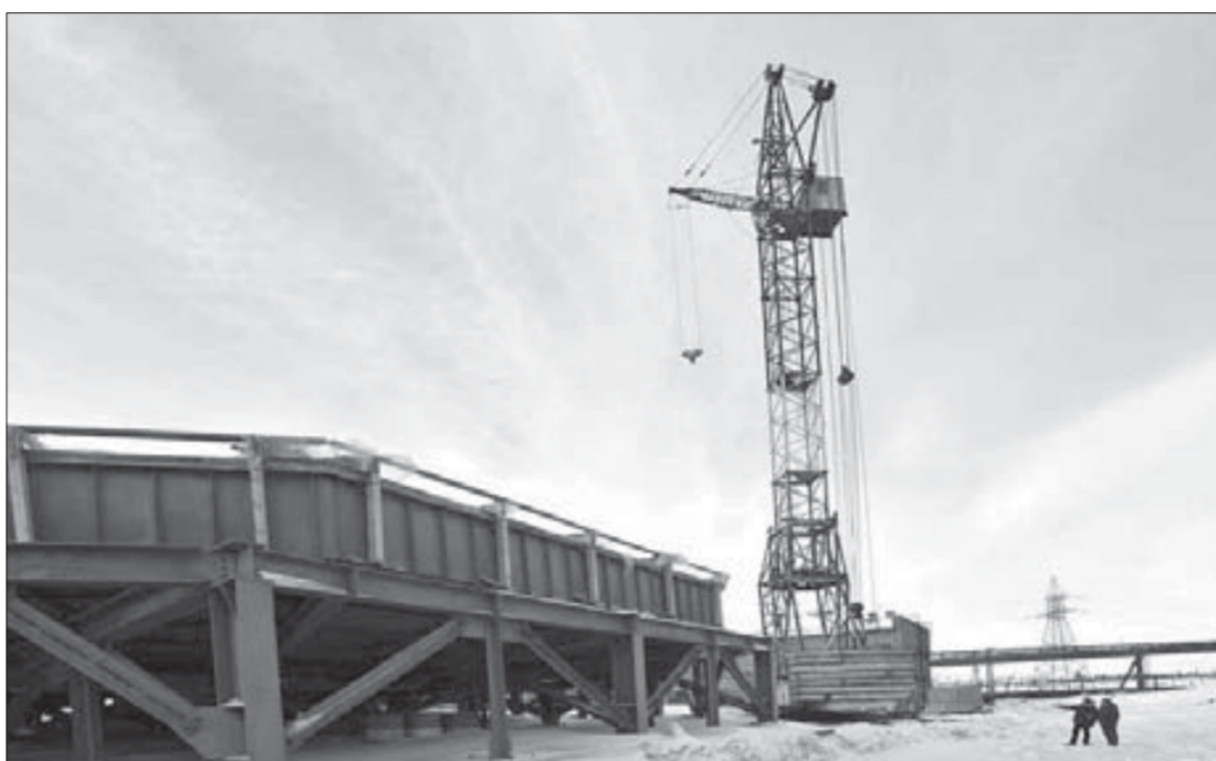
Новая градирня будет сдана в августе
