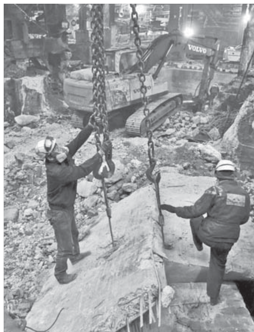
На месте, где была печь, работают техника и люди
