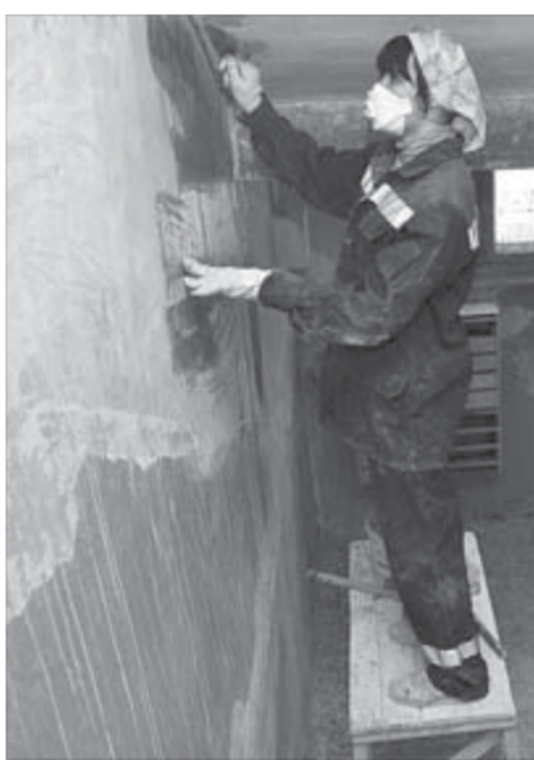
На ремонт одного подъезда уходит 10-12 дней
