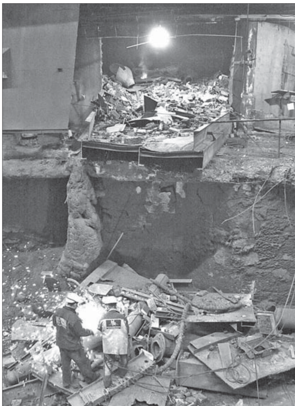
Участок №49 "Норильскиремонта" приступил к демонтажу корпуса печи, подготовил склиз для последующей скреперовки пола из печи
