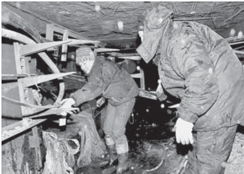
Прокладка нового оптоволоконного кабеля
