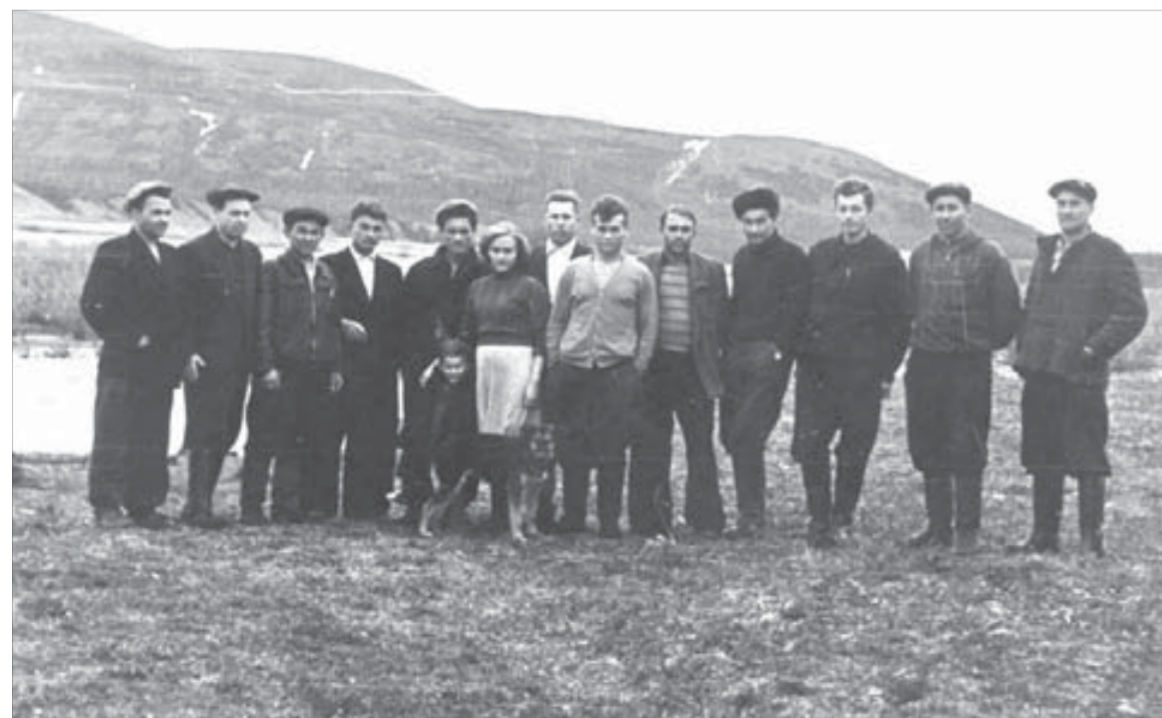
Бригада буровиков скважины КЗ-21. Супруги Мицкевич стоят рядом. Август 1960 г., Талнах
