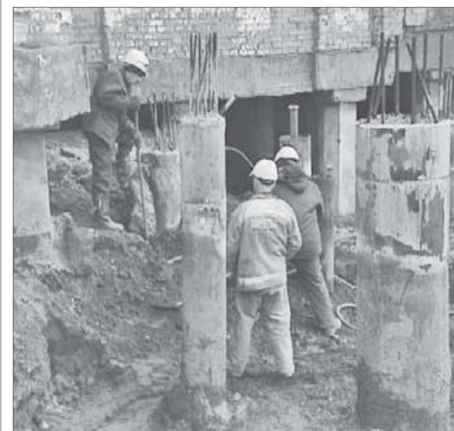
Работы на стадионе уже начались
