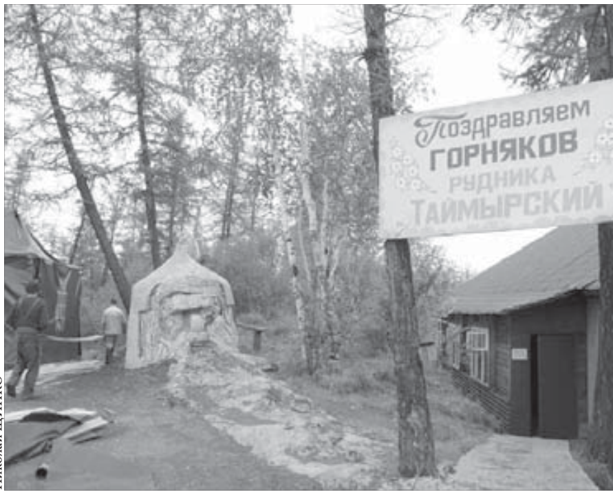
Последние штрихи в предпраздничном ремонте
