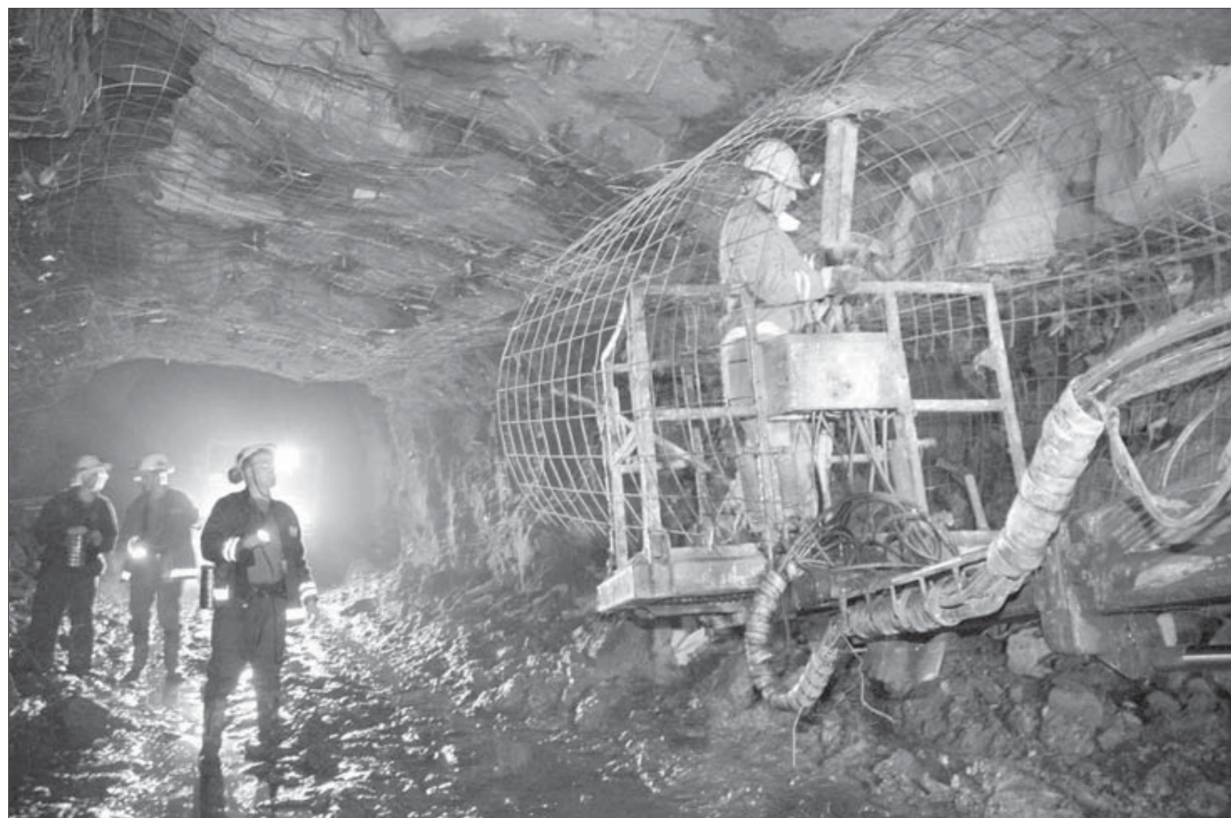
Прочная кровля – залог безопасности
