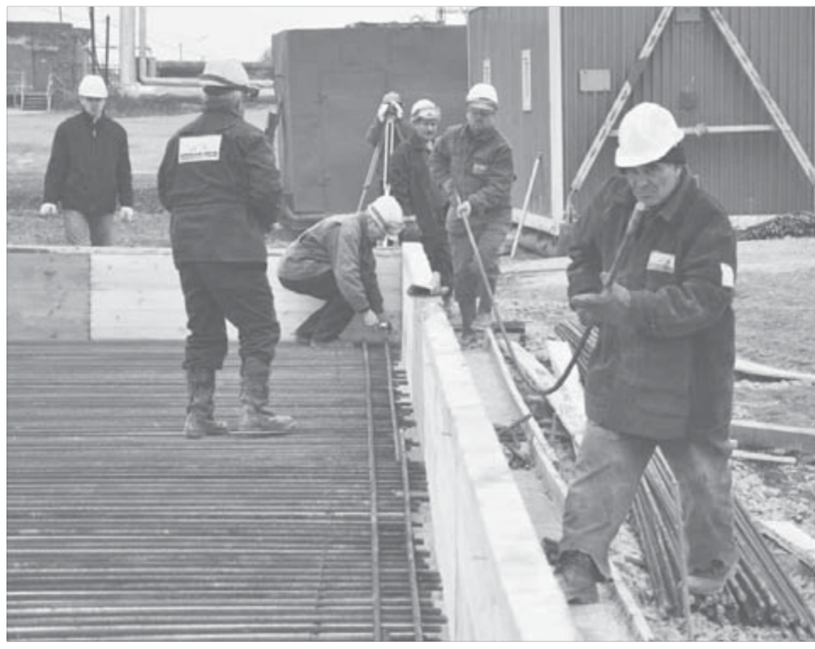
Восстановительные работы идут полным ходом
