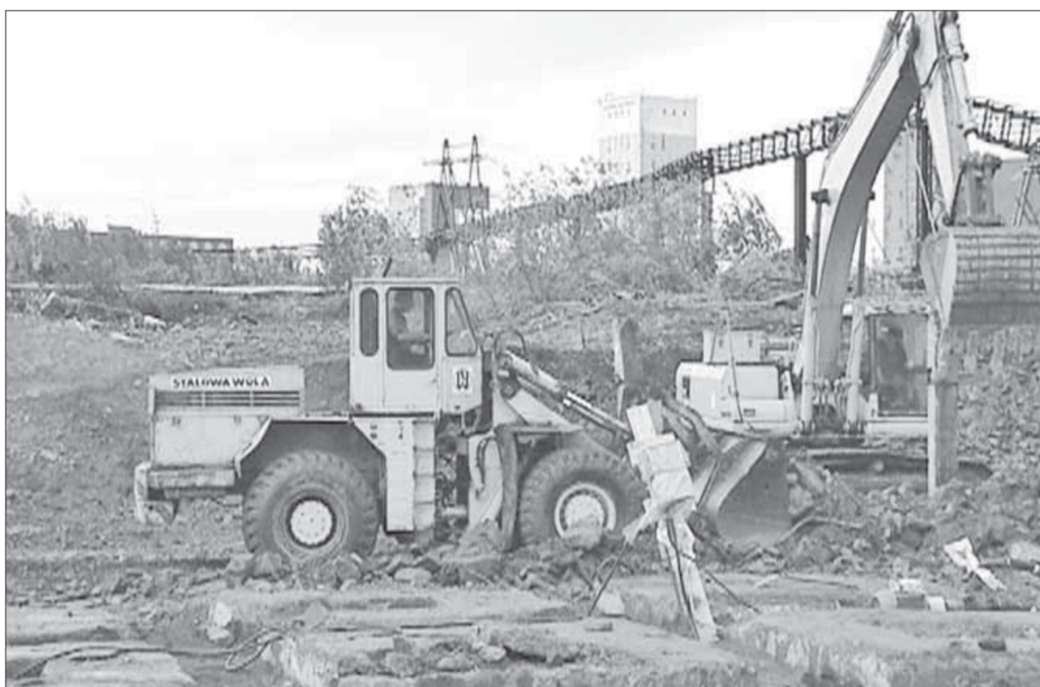
Идет подготовка площадки под строительство
