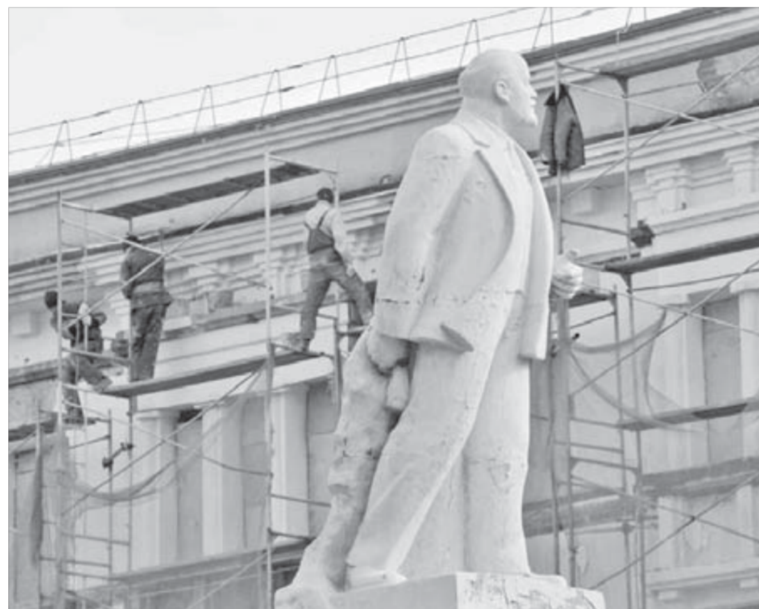
Наиважнейшим для нас является... ремонт
