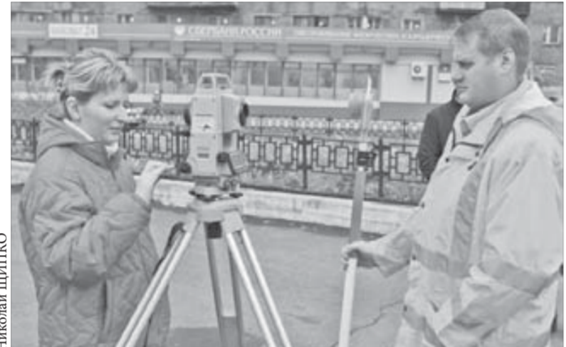
Качество ремонта проверяется поэтапно
