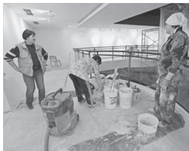
В галерее пока стройплощадка
