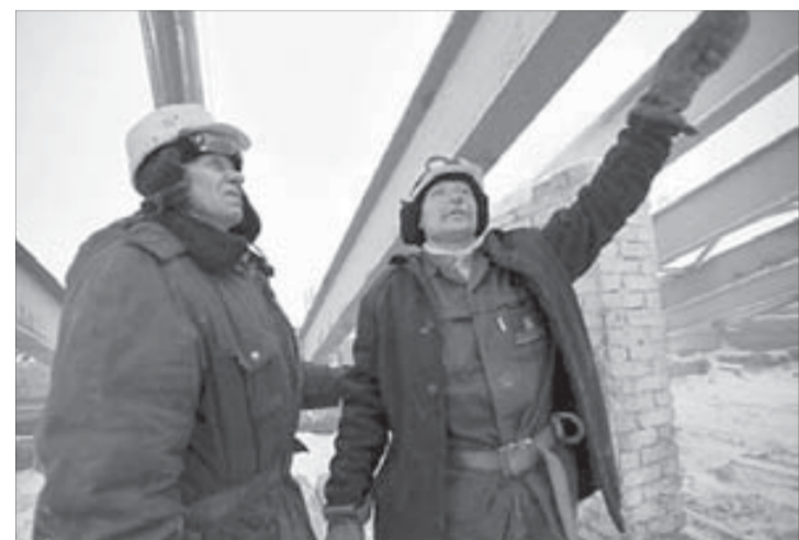
Работу по восстановлению кровли ведет бригада Николая Пинчукова
