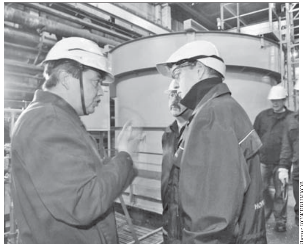
Новое оборудование установлено в измельчительно-флотационном цехе НОФ
