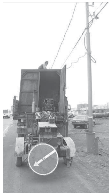
Готовится освещение – объезд!
