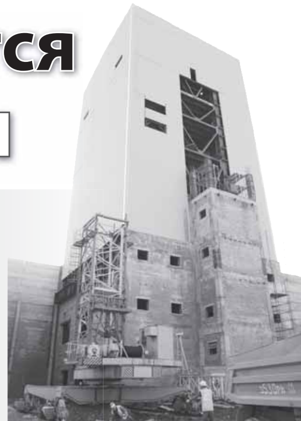
Строуправлению и сейчас работы хватает
