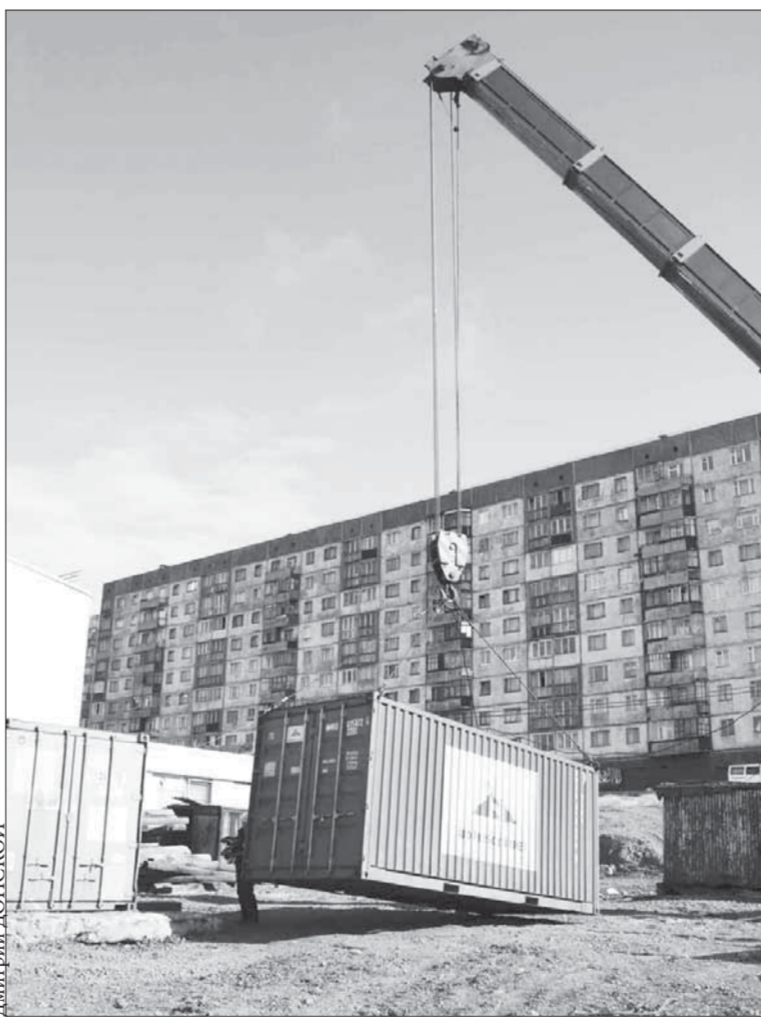
В этих контейнерах - будущее норильского хоккея
