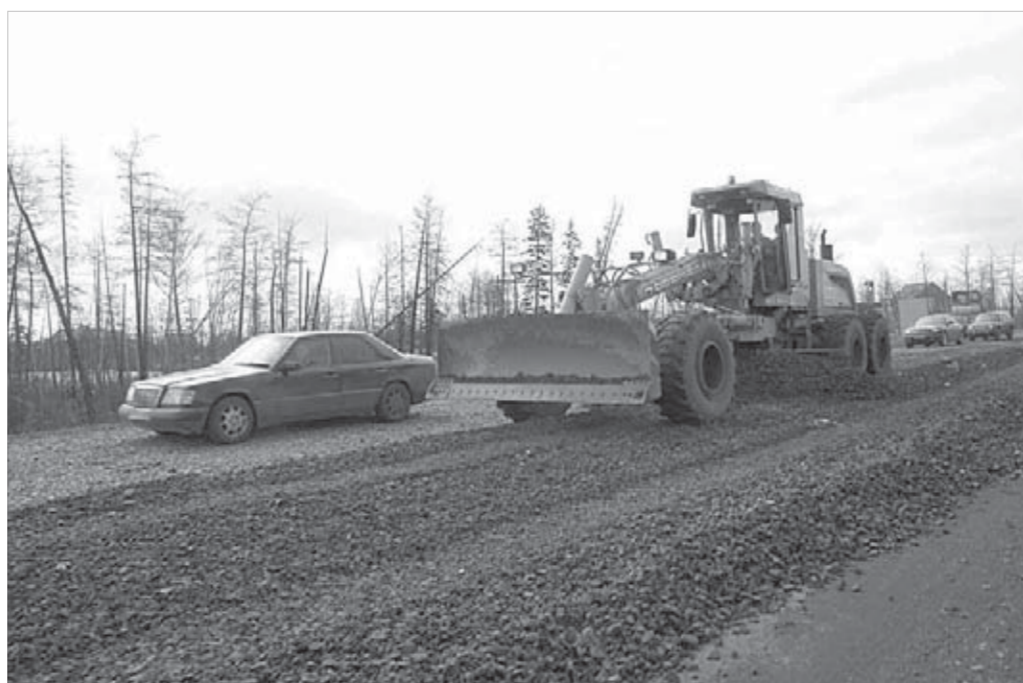
Идет отсыпка дороги
