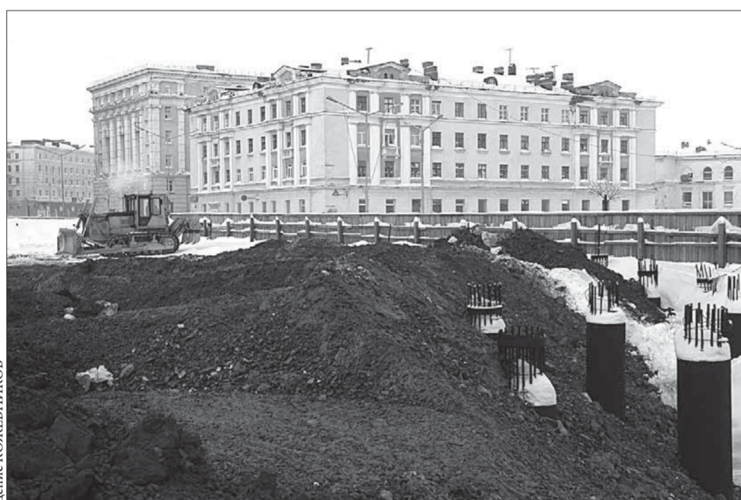
Котлован превращается в городской сквер
