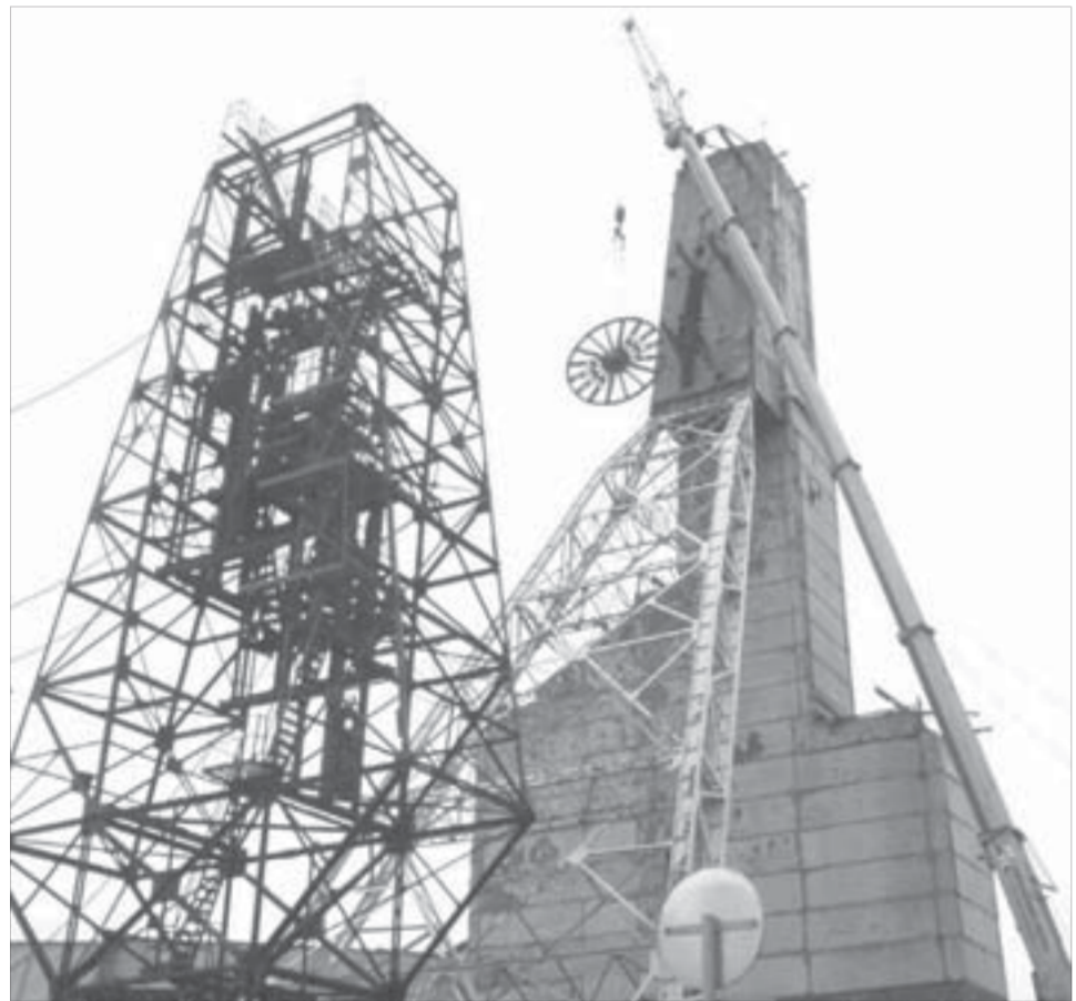
Замена шеститонного шкива
