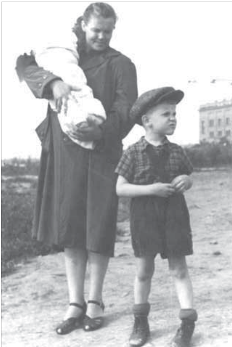
Елена Германовна на прогулке с Олегом и Мариной. Константин Михайлович сфотографировал семью и строительную площадку будущего бассейна
