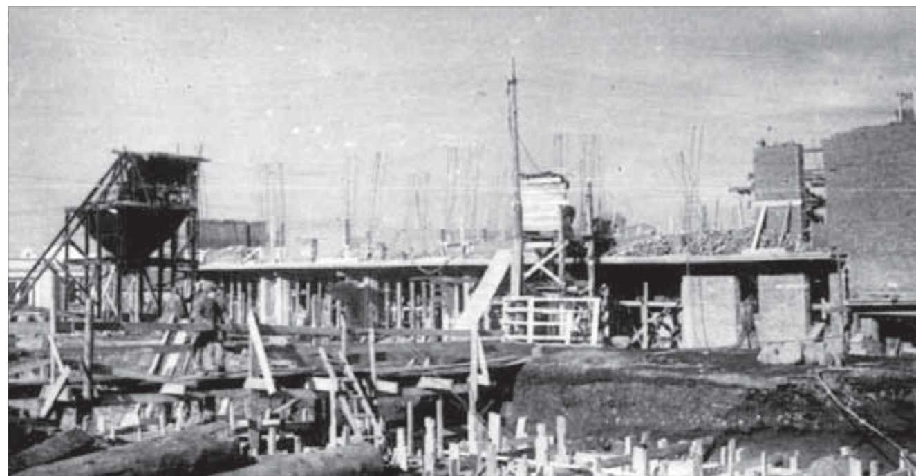
Строительство коксохимического завода (1947 год). Фото из фондов Музея истории освоения и развития ННП
