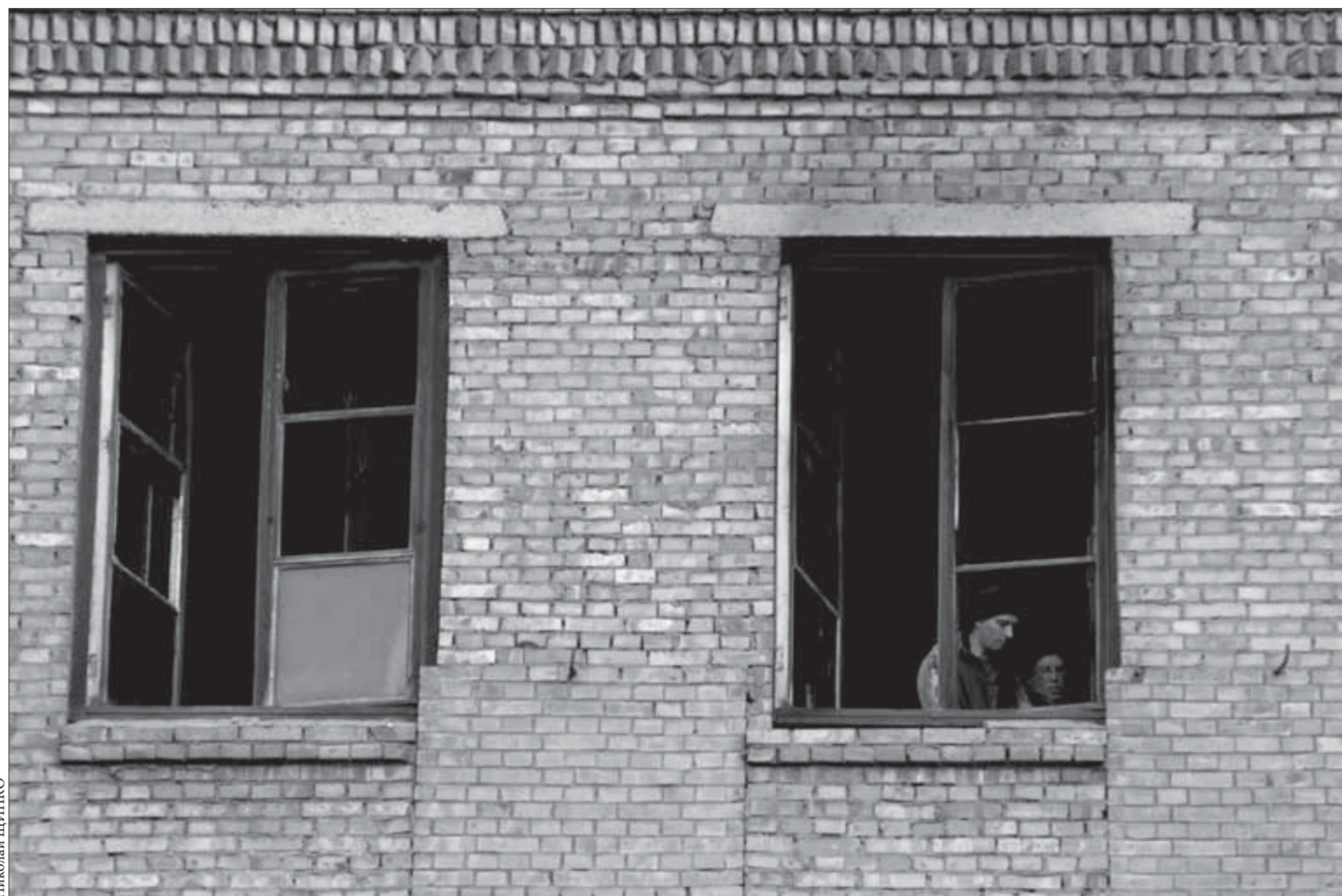
Разбитые стекла заменяют новыми
