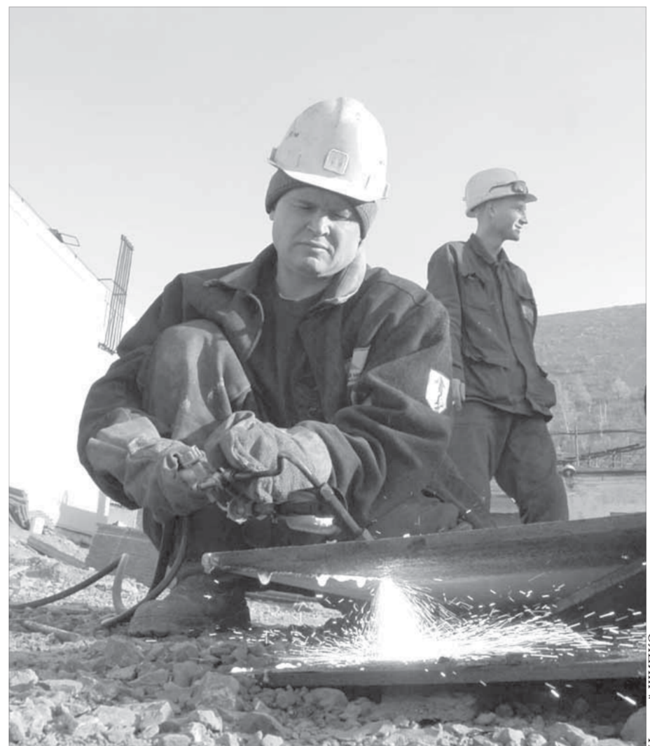
Ремонт закончат в конце сентября
